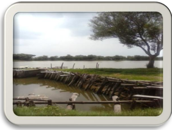
Gambar 6 : Pematang Tambak Yang berdiameter 30 cm
