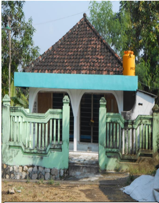
Gambar 3.8 : Kondisi musolla di Dusun Banyulegi
