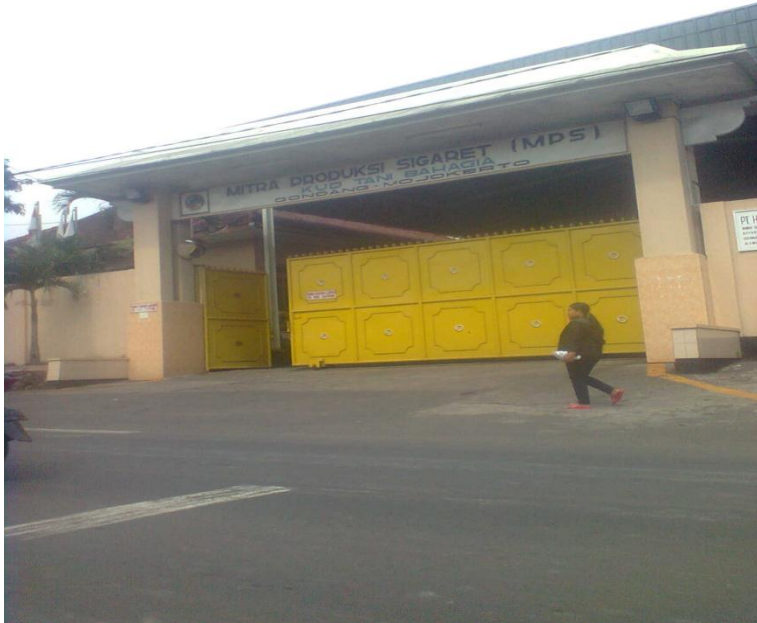
Gambar yang menunjukkan pabrik Sampoerna tampak dari depan.
