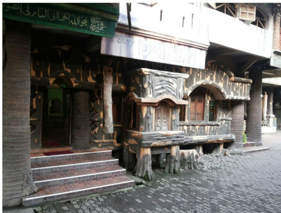
Gambar 4.8 Bangunan atas pondok tampak dilihat dari bawah
