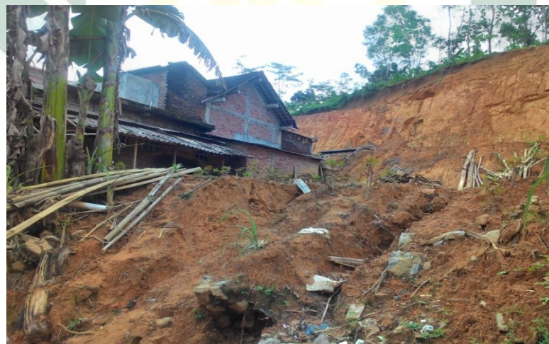
Bencana Longsor di Dusun Gares di Ambil dari Bawah Bukit
