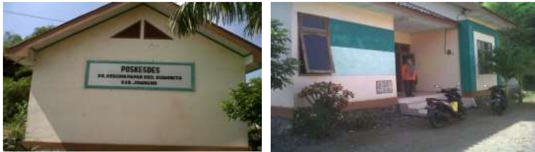
Gambar 1.3 Pembangunan Gedung Poskesdes Sebagai Fasilitas Kesehatan Desa Kedungpapar pada Tahun 2010 40
