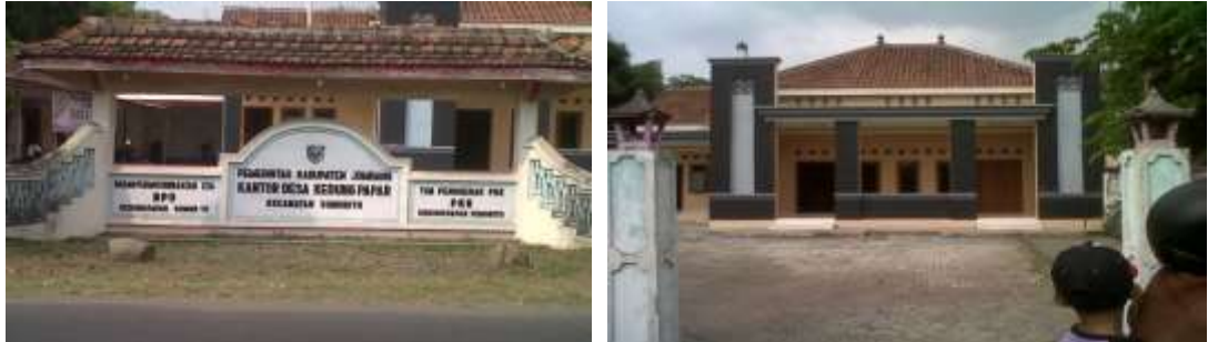
Gambar 1.2 Renovasi Gedung Balai Desa pada akhir Tahun 2013 39
