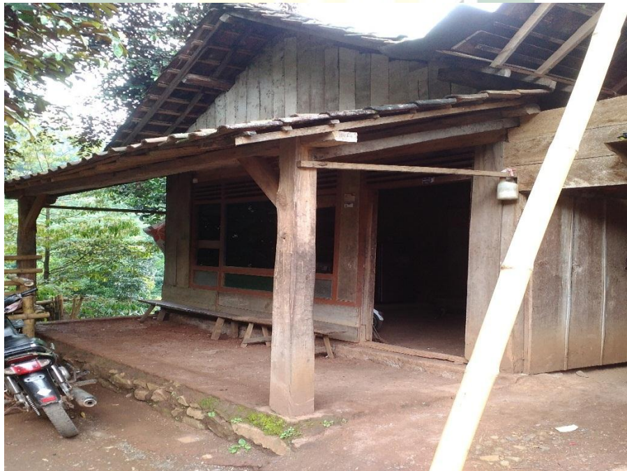
Gambar 4.1 Rumah Dalam Pondasi Kayu
