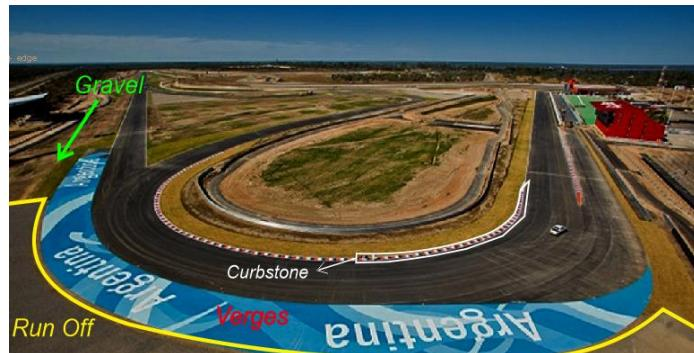
Gambar 2.2 *Gravel, Curbstone, Verges* dan *run off* pada sirkuit
