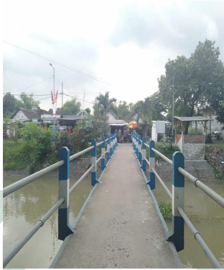
Gambar 4.1 Segmen 1 Sungai Pelayaran yang Terletak di Kecamatan Balongbendo
