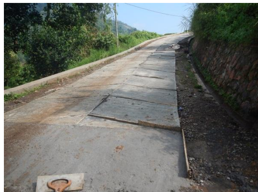
Gambar 1.4 : Jalan Rabat Beton yang Baru Dibangun
