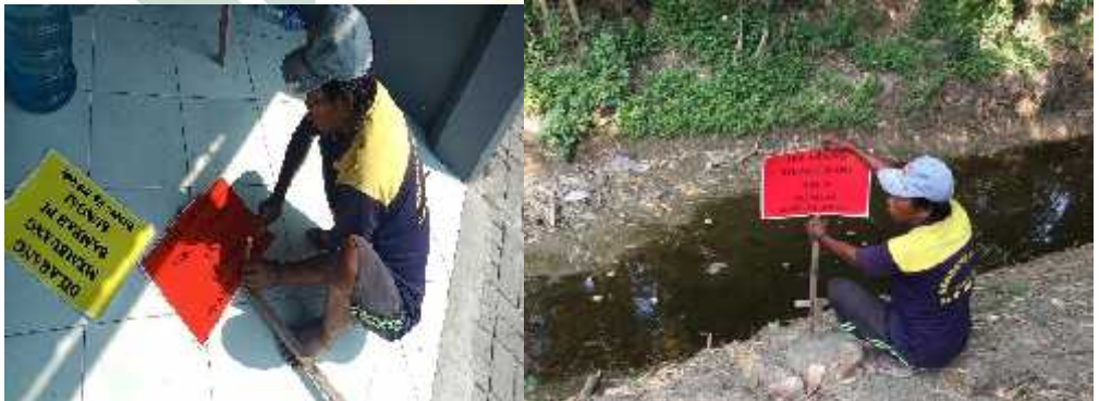
Gambar 5.6 Pemasangan papan larangan
