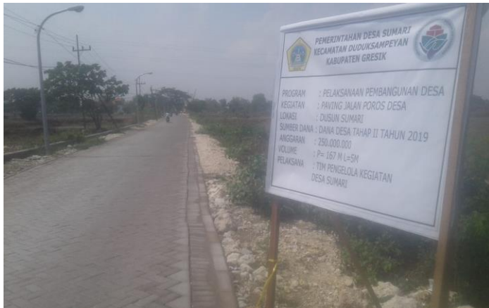
Gambar 4.3 Kegiatan Pavingisasi di desa Sumari, pada Jalan Lintas Desa.
