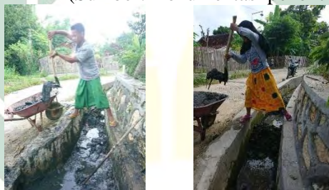
Gambar 7. 7 Pemuda yang sedang membersihkan endapan lumpur dan sampah di selokan (Sumber: Dokumentasi peneliti)
