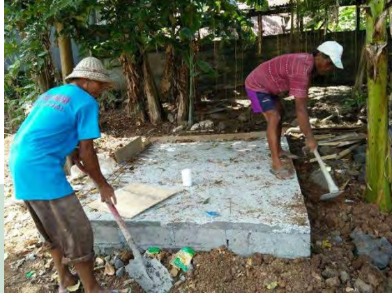
Gambar 5.20 Membangun Saptik tank
