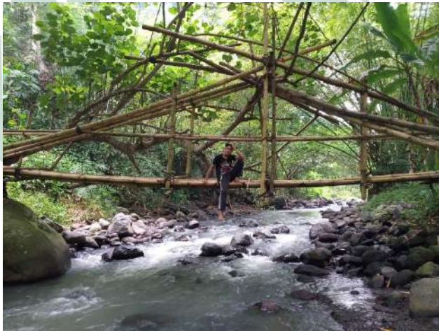
Gambar 6.4 Jembatan penghubung desa
