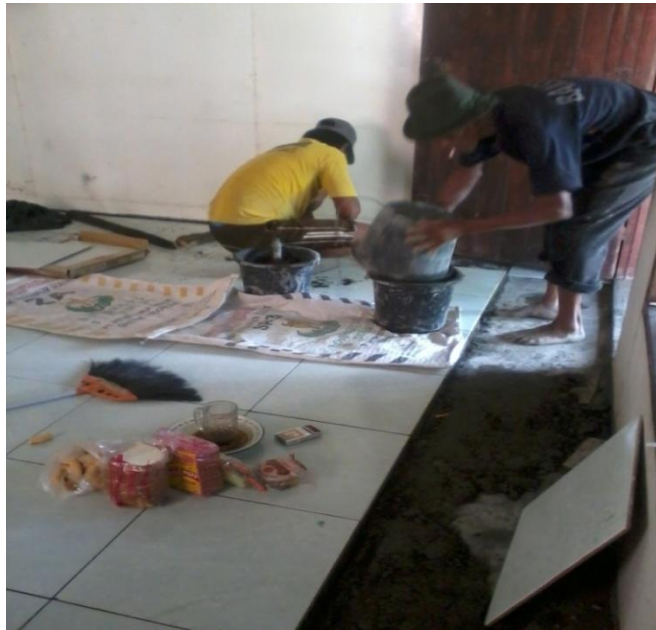
Gambar 3.6 Bapak Sumarto sebagai tukang yang sedang memasang ubin
