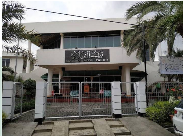
Gambar 0.1 Masjid Baitul Falah Tampak Depan
