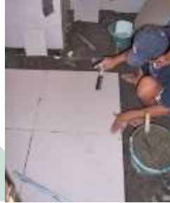
Gambar 4.2 Aktivitas Pemasangan Ubin
