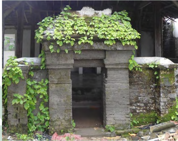
Sumber: Dokumen Yayasan PP Sunan Drajat Gambar 3.7 paduraksa atau kori penghubung kompleks makam
