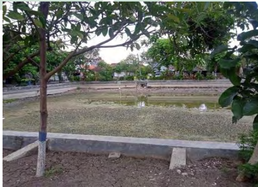
Gambar 5.11 Pembangunan Telaga Untuk Warga Banjarmasin
