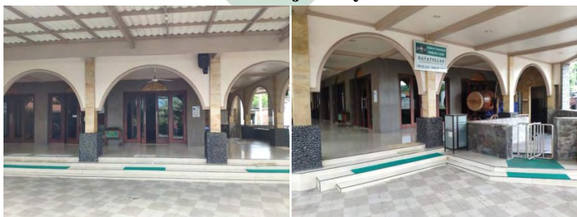
Gambar 4.6 Kondisi Masjid Hayatullah
