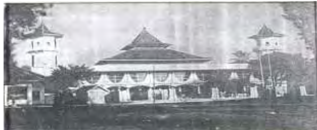
Bangunan masjid setelah renovasi pada tahun 1985
