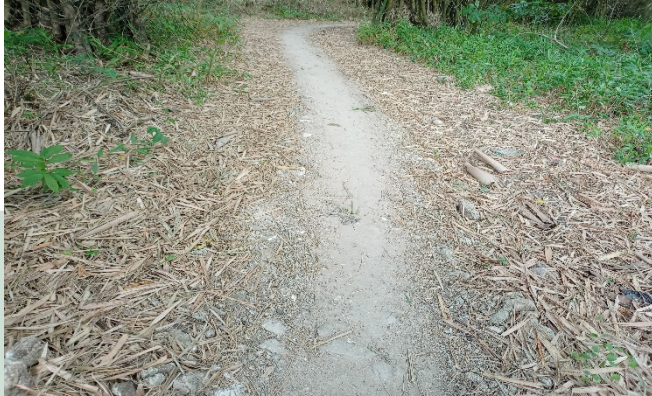
Gambar 5.8 Jalan tanah campur batu
