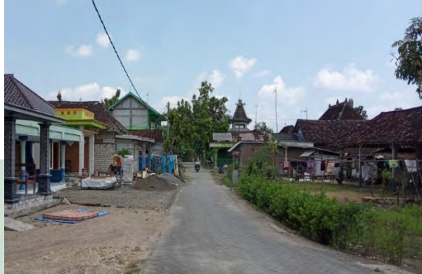
Gambar 5.4 Kondisi Jalan Desa
