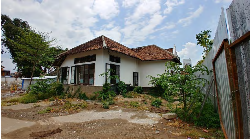
Gambar 8 Eksisting bangunan rencana gedung kantor
