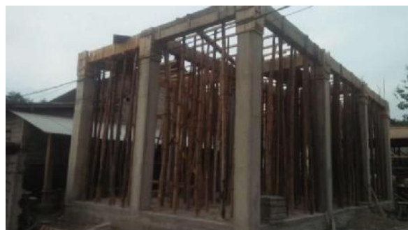
Gambar 4. 14 Proses Pembangunan Pondok
