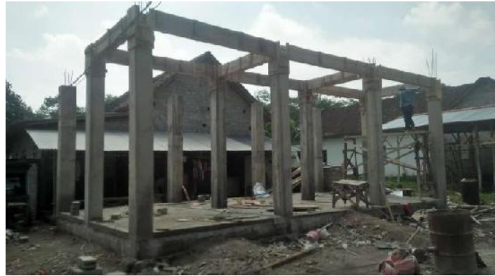
Gambar 4. 15 Proses Pembangunan Pondok
