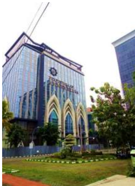
Gambar 4. 1 Gedung Perpustakaan UIN Sunan Ampel Surabaya
