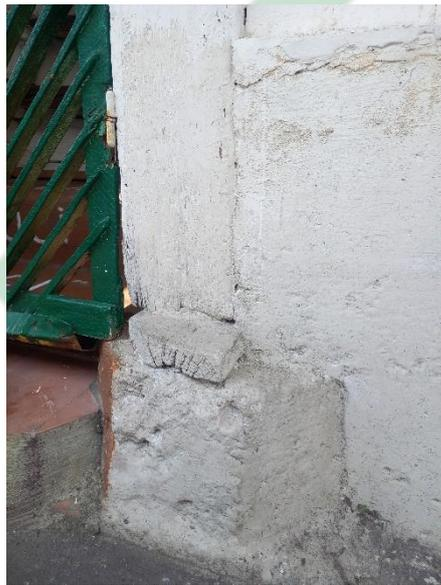
*Gambar 4.9 umpak segi delapan yang menjadi pondasi di langgar*
