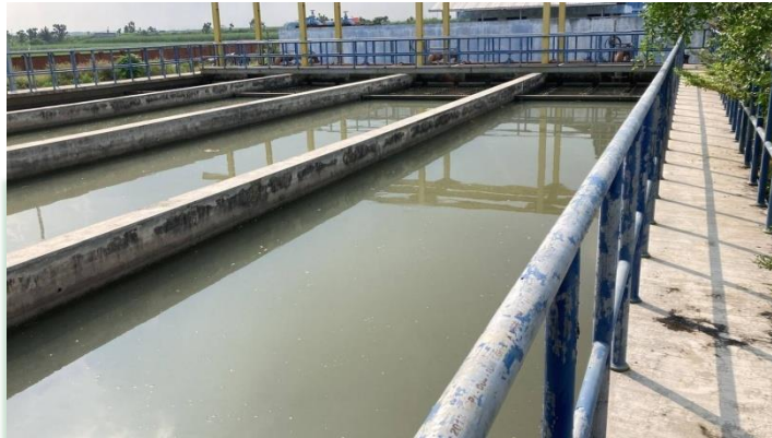
Gambar 4. 2 Prasedimentasi IPA Gedek (Sumber: Dokumentasi probadi, 2022)
