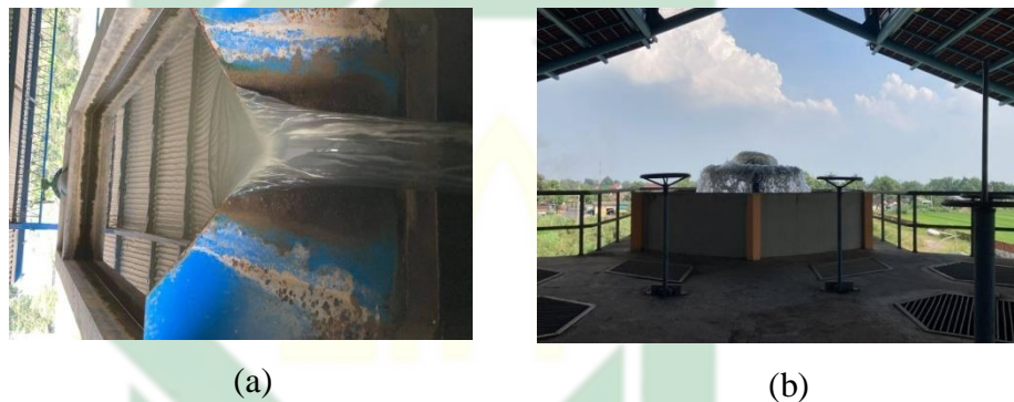
Gambar 4.3 Unit Koagulasi (a) IPA 1 Gedek; (b) IPA 2 Gedek (Sumber: Dokumentasi pribadi, 2022)
