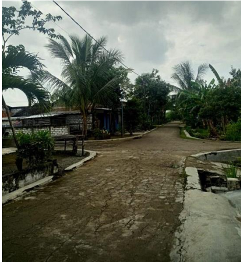
Gambar 11 Aset Fisik Jalan
