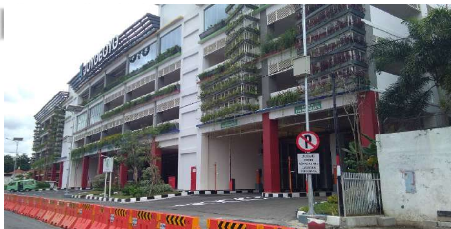
Gambar 4. 2 Pintu Keluar Terminal Intermoda Joyoboyo
