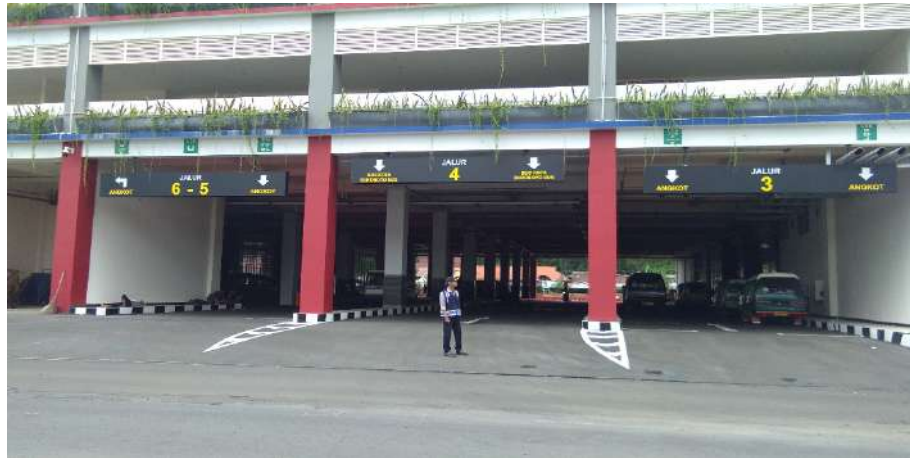
Gambar 4. 1 Pintu Masuk Terminal Intermoda Joyoboyo
