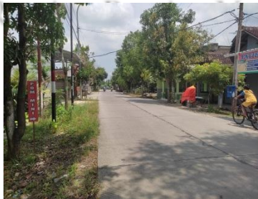
Gambar 5. 7 Kondisi yang di Cor
