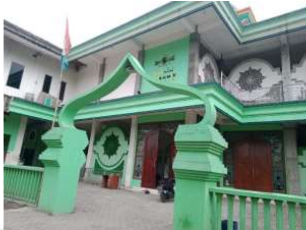
Gambar 3. 5 Bagian Depan Masjid Al-Badri Sumber: Dokumentasi Pribadi 31 Desember 2022
