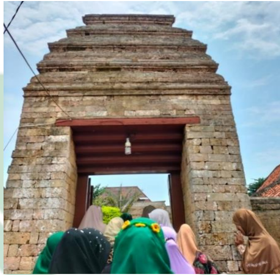
Gambar 4.4 Gapura Paduraksa -2 Sumber: Dokumen Pribadi, tanggal 5 Maret 2022.
