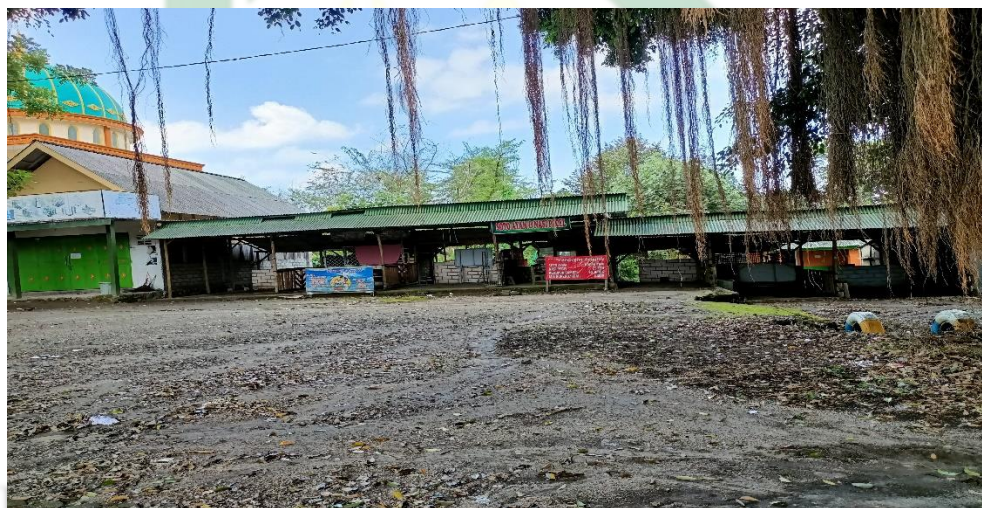
Gambar 3.10 Bangunan Kios Wisata Kampoeng Anggrek
