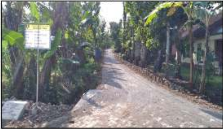
Gambar 5. 3 Kondisi Jalan Yang Sudah Dipaving
