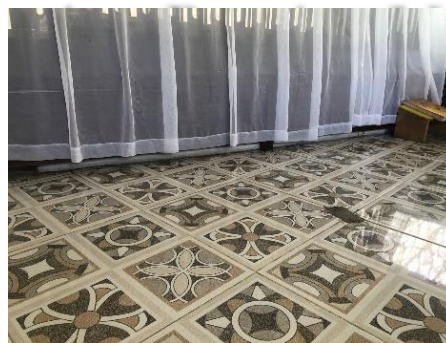
Gambar 3.7 Lantai Mbah Djaelani tampak samping (kiri) ; tampak depan (kanan) (Sumber: Dokumentasi Pribadi)
