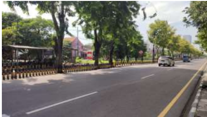
Gambar 4.7 Kondisi Lapangan Titik 6
