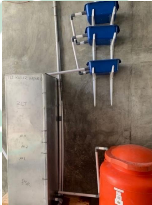
Gambar 5.11 Filter Sederhana Penurun Kandungan Zat Kapur Pada Air Tanah
