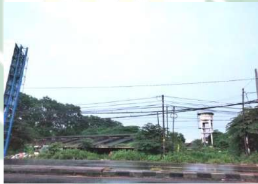
Gambar 2. 1 Bangunan Bekas Pabrik Gula Brangkal (Sumber : Dokumen Pribadi pada 20/11/2022)
