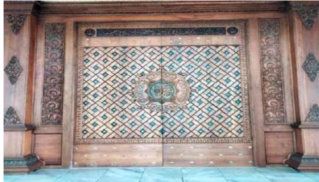
Gambar 4. 16 Pintu pada Masjid baru Darussalam (Sumber : Dokumentasi Pribadi pada 28/9/22)
