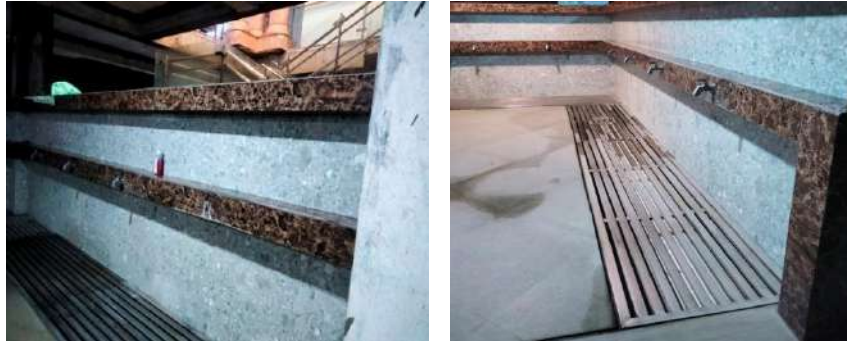
Gambar 4. 18 Tempat Wudhu di ruang bawah tanah Masjid baru Darussalam (Sumber : Dokumentasi Pribadi pada 28/9/22)
