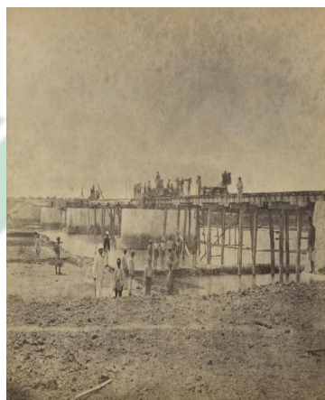
Gambar 2.2 Jembatan Rel Kereta Api Kertosono
