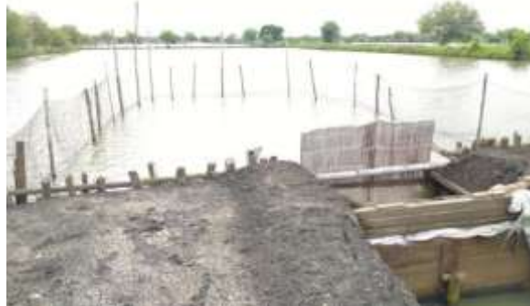
Gambar 4. 33 Waring di Areal Pintu Masuk Air
