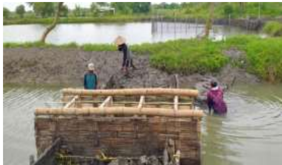
Gambar 4. 39 Pekerja Sedang Melakukan Peninggian Tanggul Tanah
