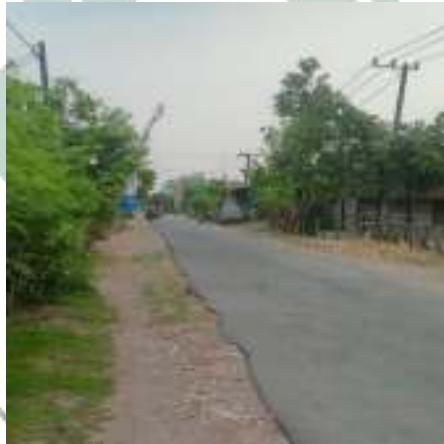
Gambar 4. 3 Kondisi Jalan Dusun Pulo
