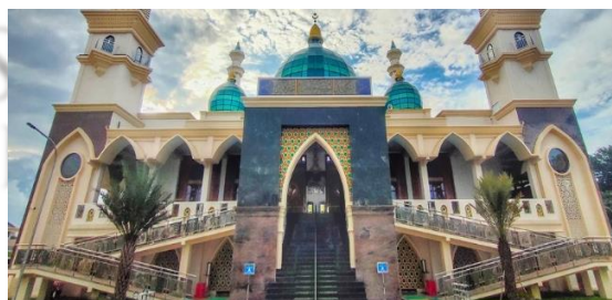
Gambar 3.16 tangga pada pintu utama masjid (Sumber: Dokumentasi Masjid Moed'har Arifin, diambil pada tanggal 07 Oktober 2022)
