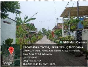
Gambar 4. 3 Kondisi Jalan Dusun Hendrosalam
