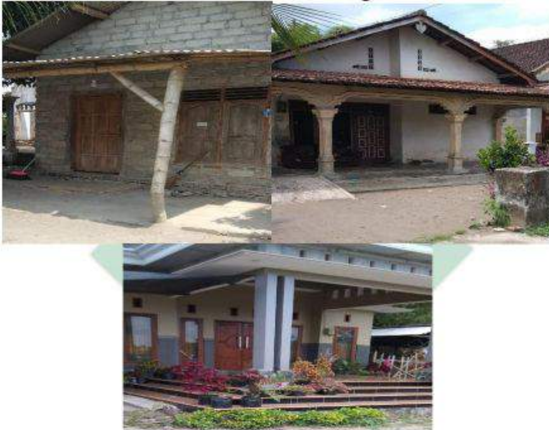
Gambar 6.6 Kondisi Rumah Warga
