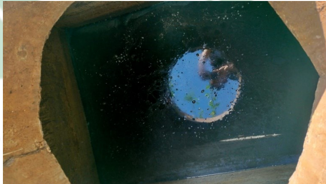
Gambar 5. 14 Kondisi Eksisting Bak Anaerobik Filter
