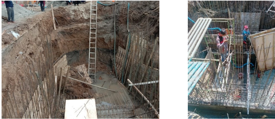
Gambar 4. 4 (kiri) Pembuatan Pondasi IPAL ; (kanan) Pembuatan Kerangka Dinding dan Kolom IPAL
