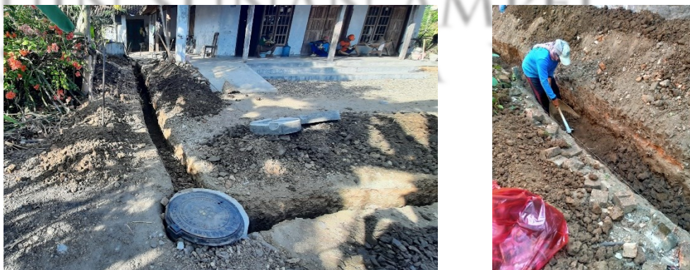
Gambar 4. 3 (kiri) Pemasangan Manhole Saluran Pipa ; (kanan) Penggalian Tanah Saluran Pipa
