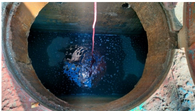
Gambar 5. 12 Kondisi Eksisting Bak Pengendap
