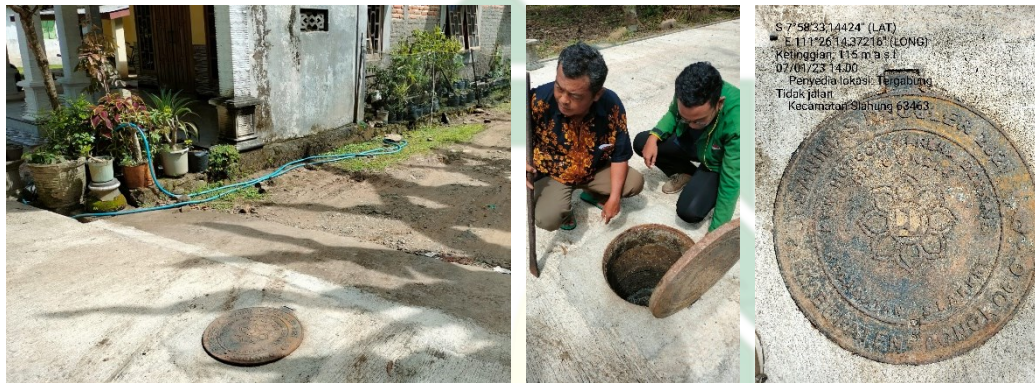
Gambar 5. 2 Kondisi Eksisting Salah Satu Manhole
