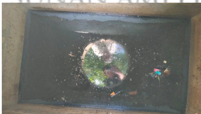
Gambar 5. 16 Kondisi Eksisting Bak Outlet
