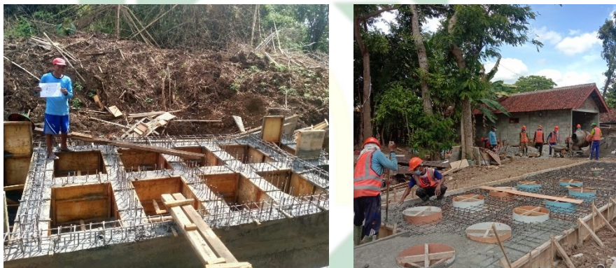
Gambar 4. 5 (kiri) Penulangan dan Cor IPAL; (kanan) Tahap Akhir Pemasangan Lubang IPAL
