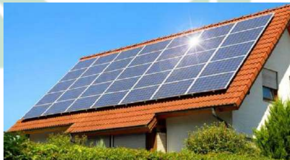
Gambar 2. 1 Pembangkit Listrik Tenaga Surya (PLTA)
