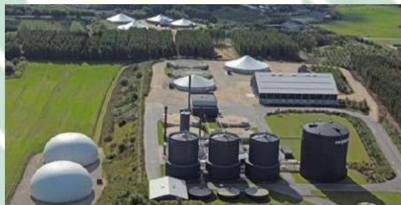
Gambar 2. 6 Pembangkit Listrik Tenaga Biogas
