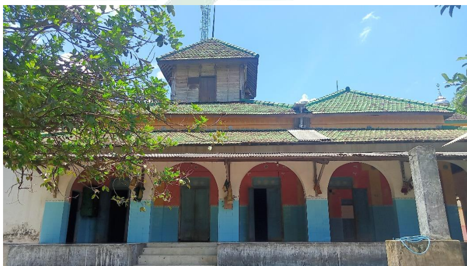
Gambar 3.25 Atap Masjid Baiturrohman (Sumber : Dokumentasi pribadi pada 16/02/2023)
