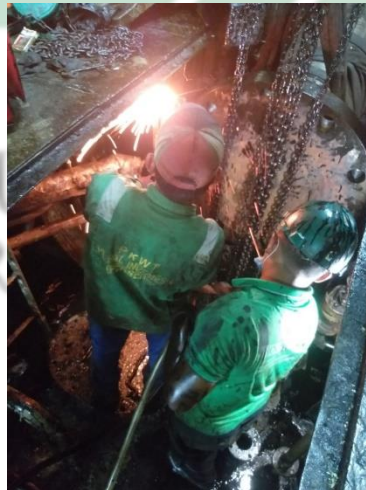
Gambar 1.2 Pekerjaan reparasi kapal di PT. Fajar Alif Makmur Surabaya
